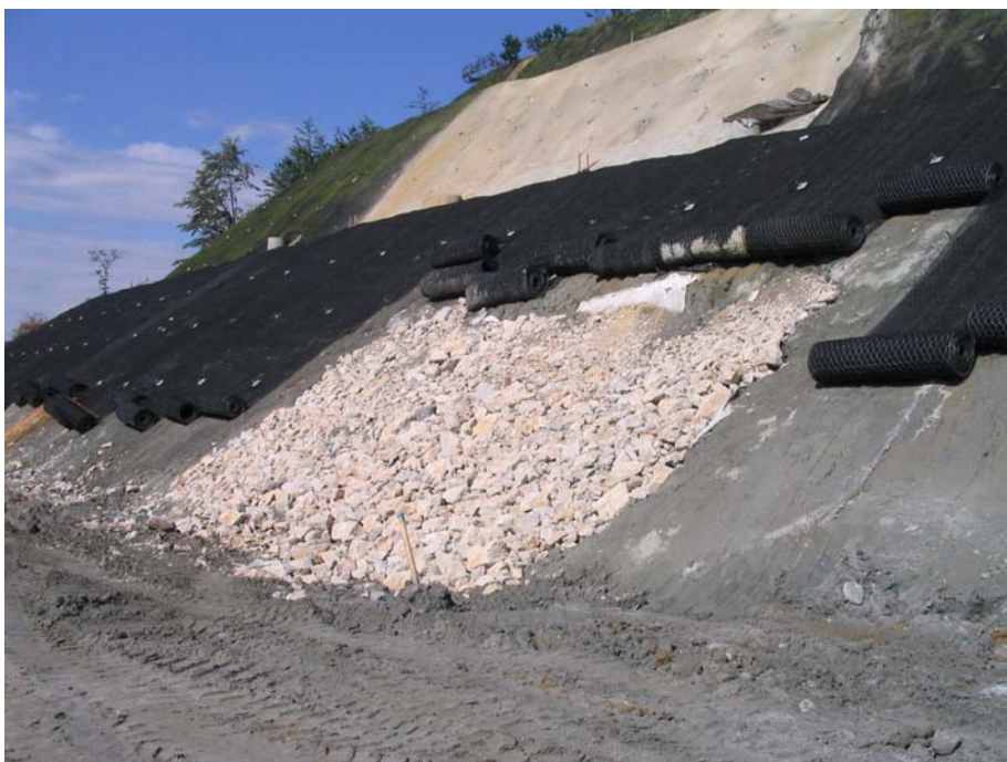
Slika 8. Kamena zamjena u zoni vlaženja kosine
