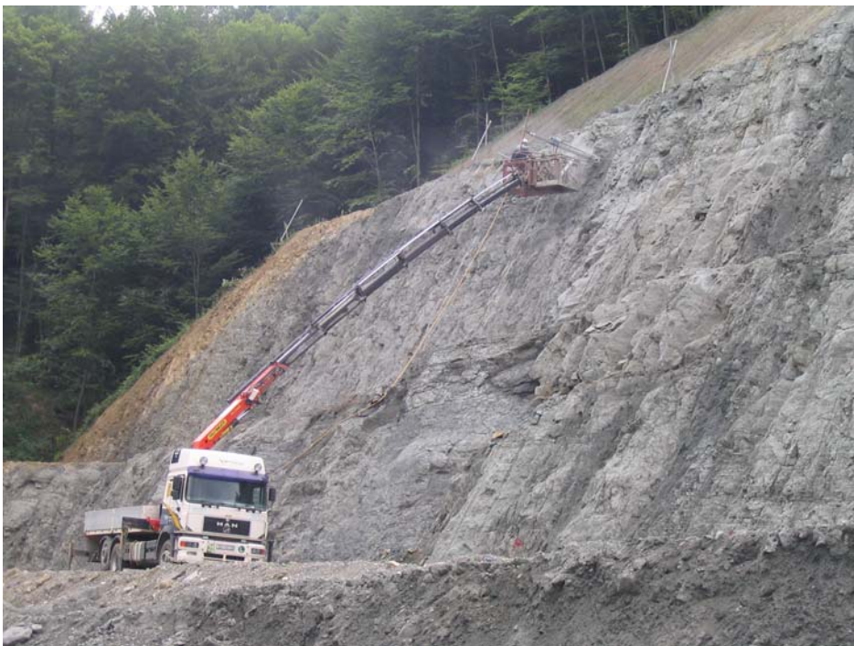
Slika 9. Izvođenje zaštite kosine sidrima na nepristupačnim zonama usjeka
