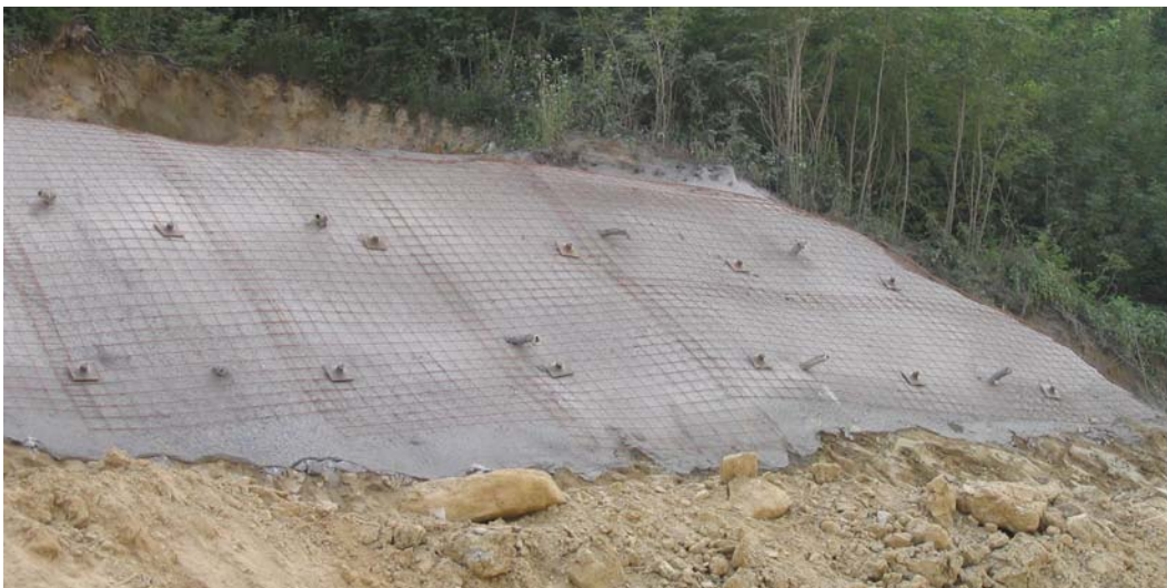
Slika 7. Zaštita kosine sidrima, mrežama i mlaznim betonom, u fazi izvođenja
