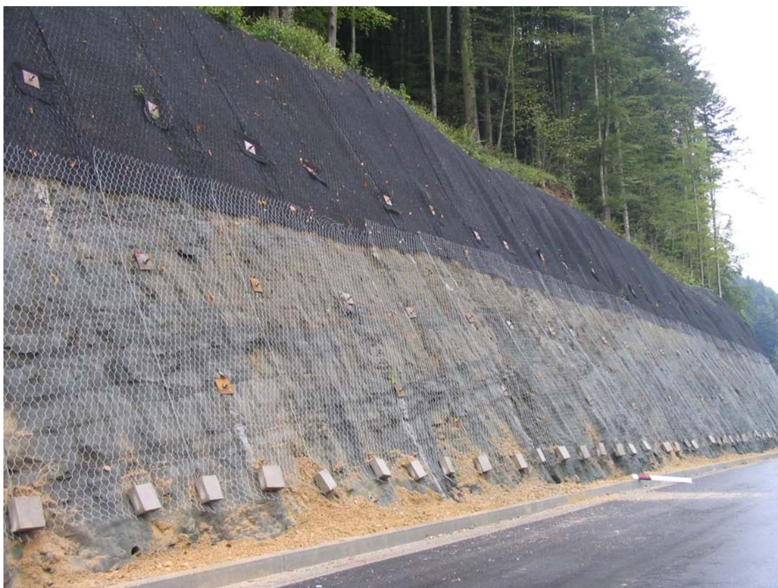
Slika 1. Kombinirana zaštita usjeka
